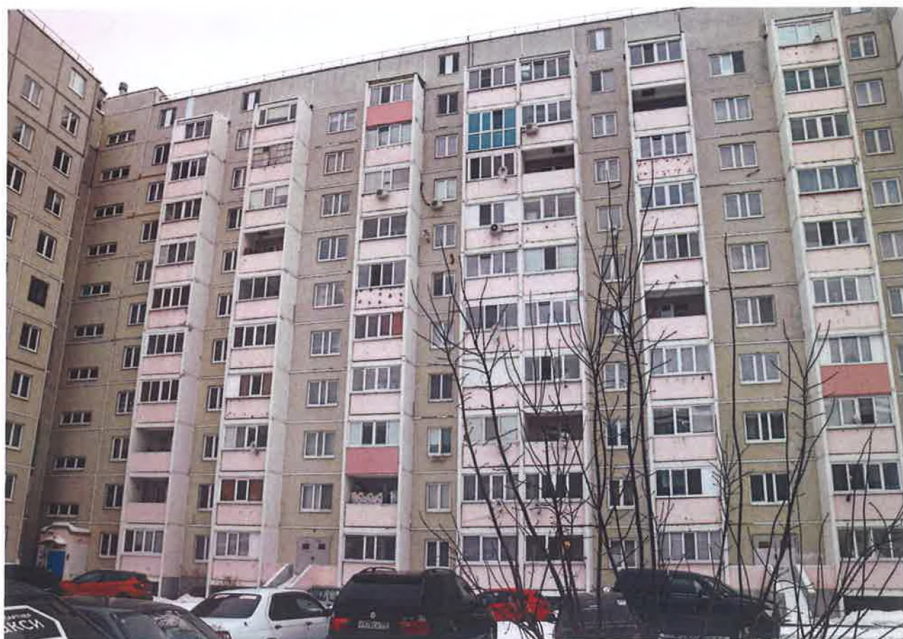
Рис. 5 Фасад в осях 7-1 со стороны ул. Жуковского
