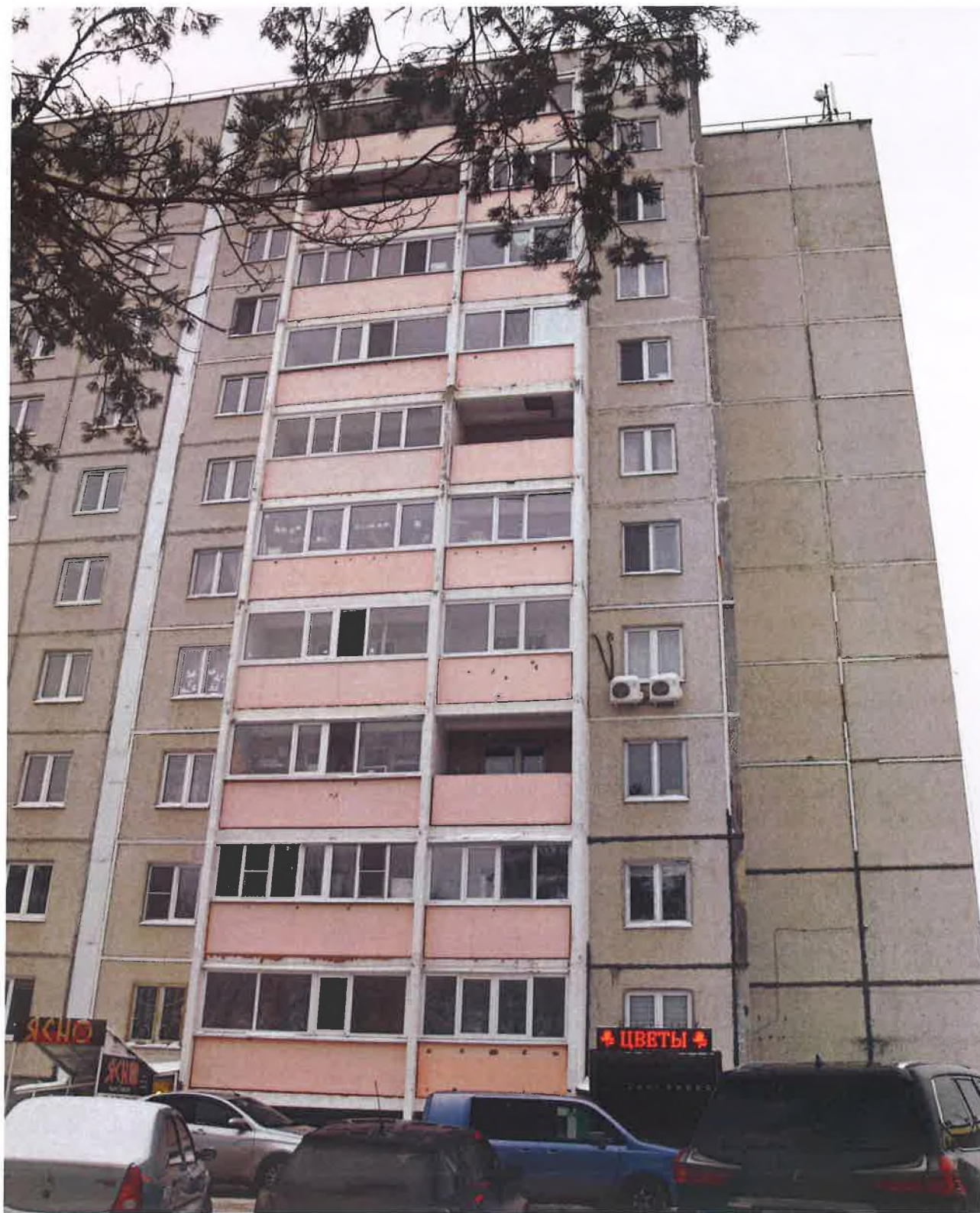
Рис. 7 Фасад в осях 3-1 со стороны Тобольского тракта
