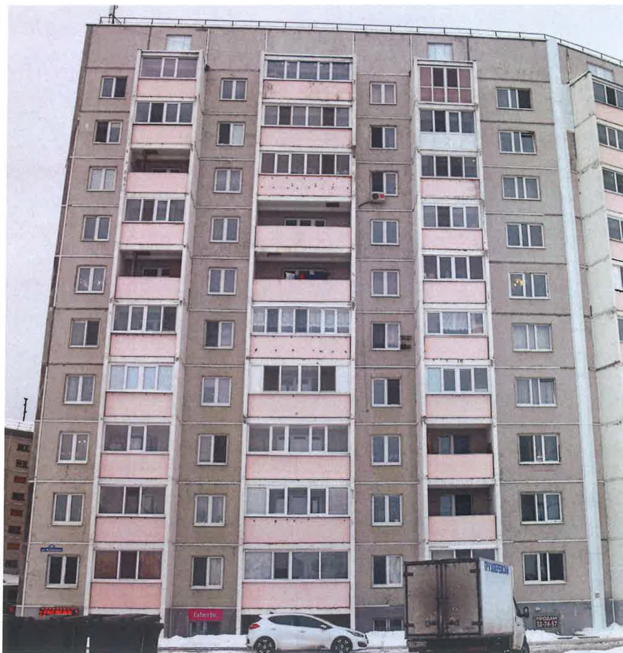
Рис. 9 Фасад в осях 9-8 со стороны Тобольского тракта
