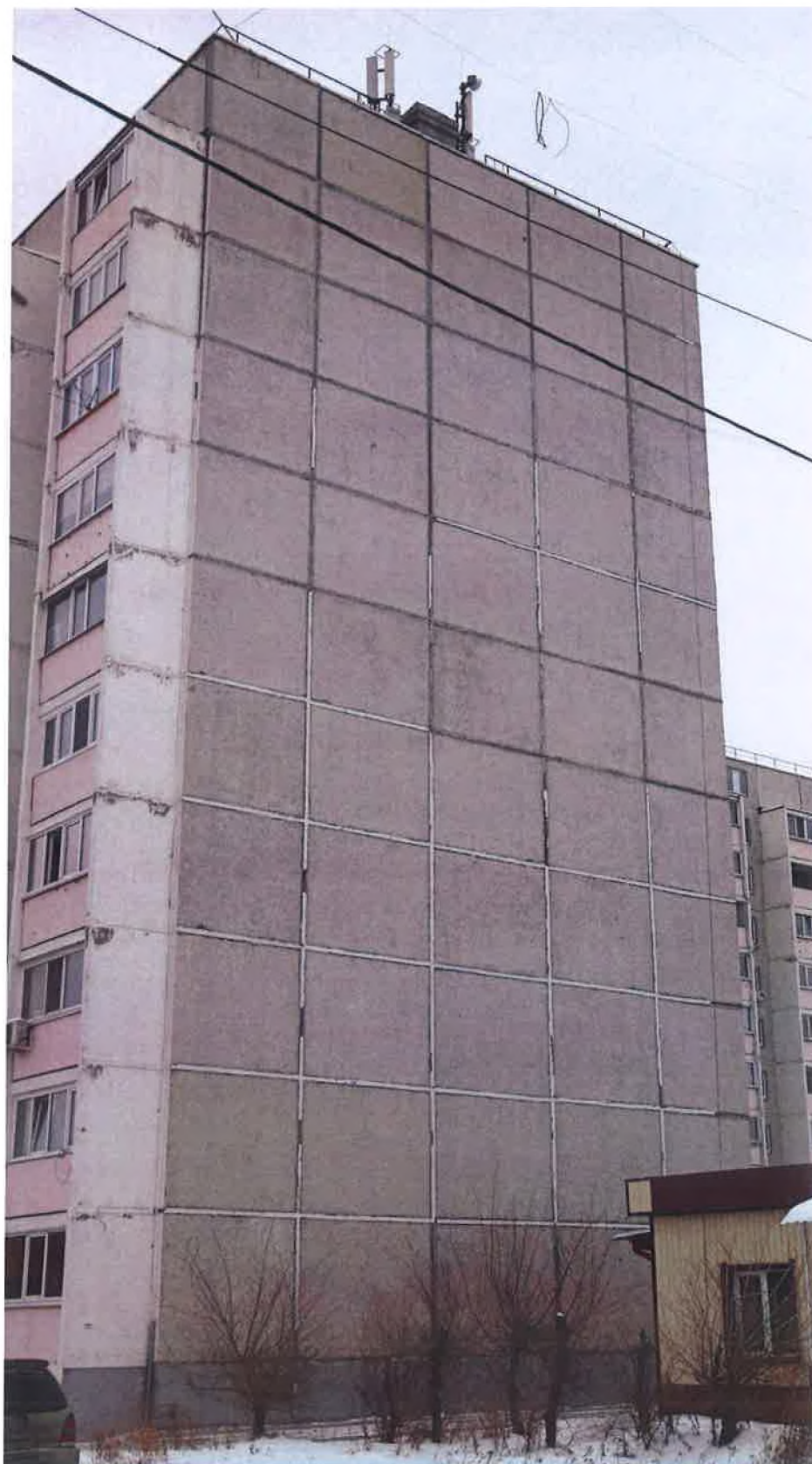
Рис. 4 Фасад в осях 1-2 со стороны ул. Жуковского
