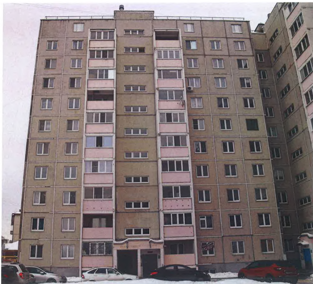
Рис. 2 Фасад в осях А-В со стороны ул. Жуковского
